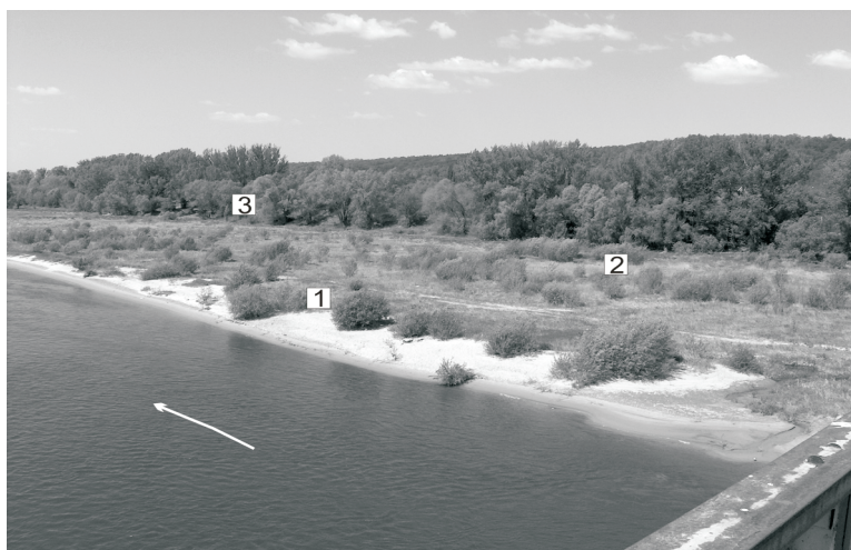
Fot. 2. Nowo utworzony poziom zalewowy ok. 4,5 km poniżej zapory (prawy brzeg Wisły): 1 – wał przykorytowy; 2 – terasa zalewowa; 3 – terasa nadzalewowa
