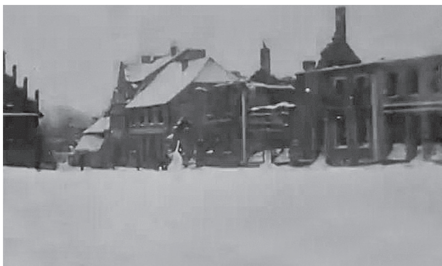
Zniszczenia w Nidzicy
