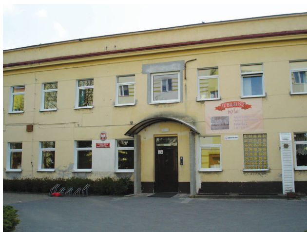
Fotografia 369. Dom Małego Dziecka „Filipek” przy ul. Stolarskiej. Wejście główne. Fot. Przemysław P. Grzybowski
