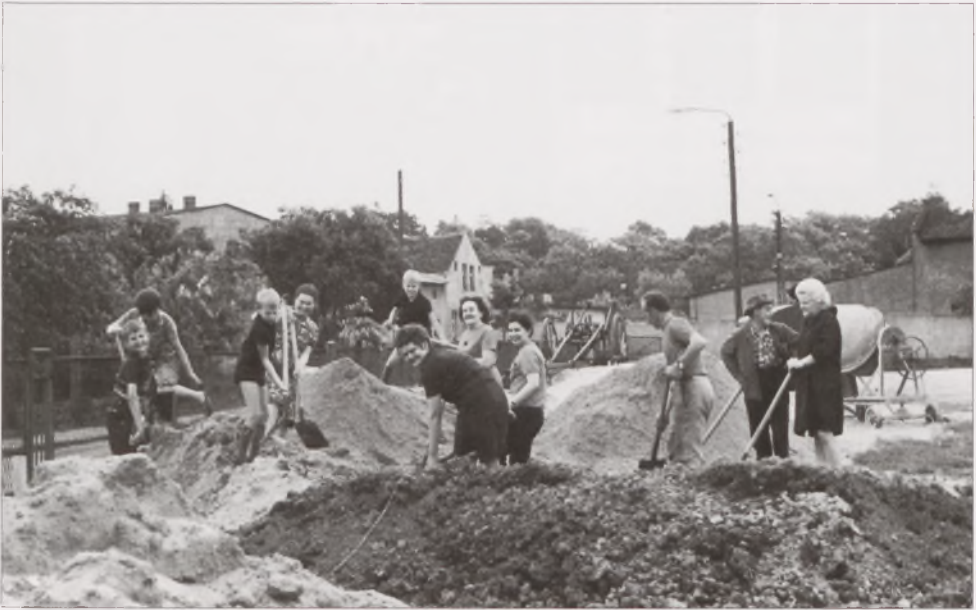
Fot. 13. Czyn społeczny – budowa Ośrodka Kultury w Mroczy. Fotografia wykonana w dniu 10 maja 1974 roku
