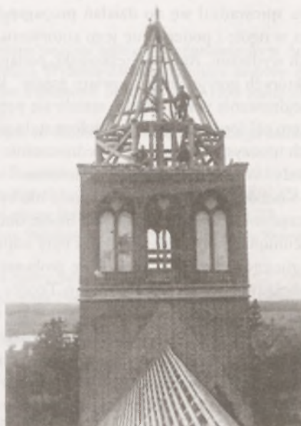
Ryc. 6. Kościół w czasie odbudowy. Zdjęcie z 1947 r.
