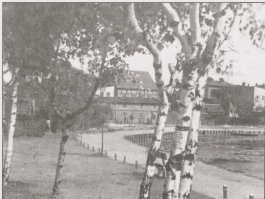
Ryc. 2. Synagoga w Więcborku - z muru pruskiego, zniszczona przez Niemców w 1939 r. (L. Skaza - „Więcbork na starej fotografii”).
