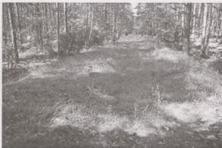
Ryc. 5. Droga na nasypie pomiędzy Wierzchucinem a Sarnówkiem
