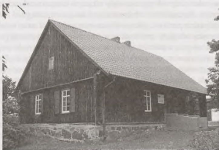
Ryc. 4. Budynek dawnej szkoły w Trzebcinach
