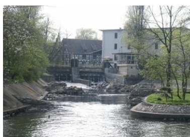
Ryc.5. Jaz Farny na Brdzie Młyńskiej, mała elektrownia wodna. fot. D. Muszyńska- Jeleszyńska
