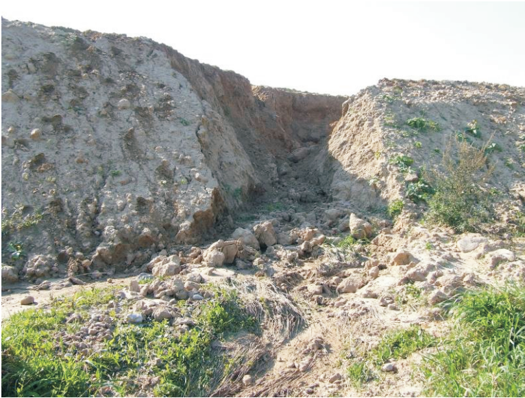
Fot. 1. Erozja wąwozowa na zboczu doliny erozyjnej w Nakle nad Notecią (fot. P. Wiśniewski, wrzesień 2006)
