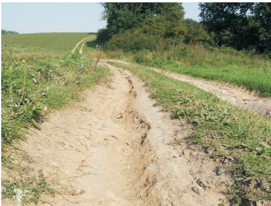
Fot. 3. Erozja żłobinowa na nieutwardzonej drodze biegnącej wzdłuż stoku na Wysoczyźnie Krajeńskiej we wsi Ślesin, gmina Nakło nad Notecią (fot. P. Wiśniewski, wrzesień 2006)
