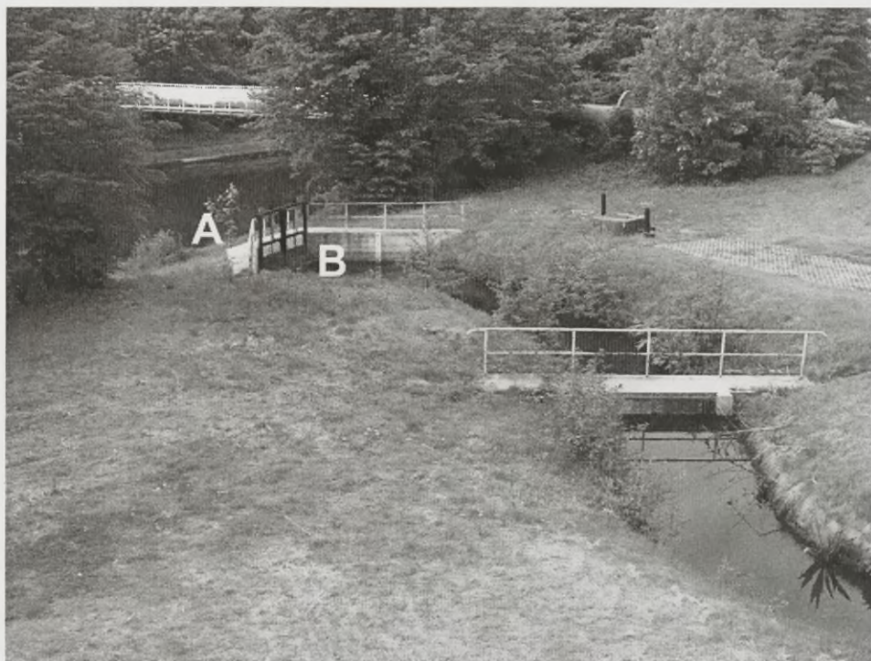
Ryc. 2. Syfon przeprowadzający strugę Flis pod Kanałem Bydgoskim. A – wlot do syfonu, B – zastawka piętrząca wodę
