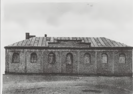
Hala gimnastyczna w budowie.
