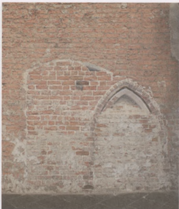
Il. 4. Podwójny portal w kościele św. Piotra i Pawła odkryty w prezbiterium w trakcie prac remontowych w 2008 r. i częściowo przykryty ponownie tynkiem w 2013 r. (fot. M.G. Zieliński).
