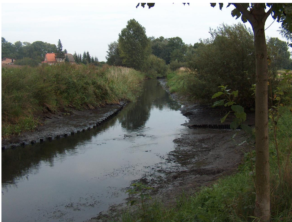
Fot. 1. Koryto Kanału głównego „A” odwadniającego polder - około 70 m przed stacją pomp (wrzesień 2008).
