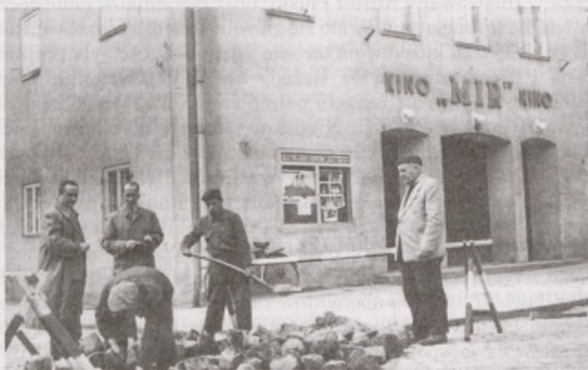
Ryc. 27. Prace remontowe przed kinem „Mir” (ze zbiorów MBT w Tucholi)
