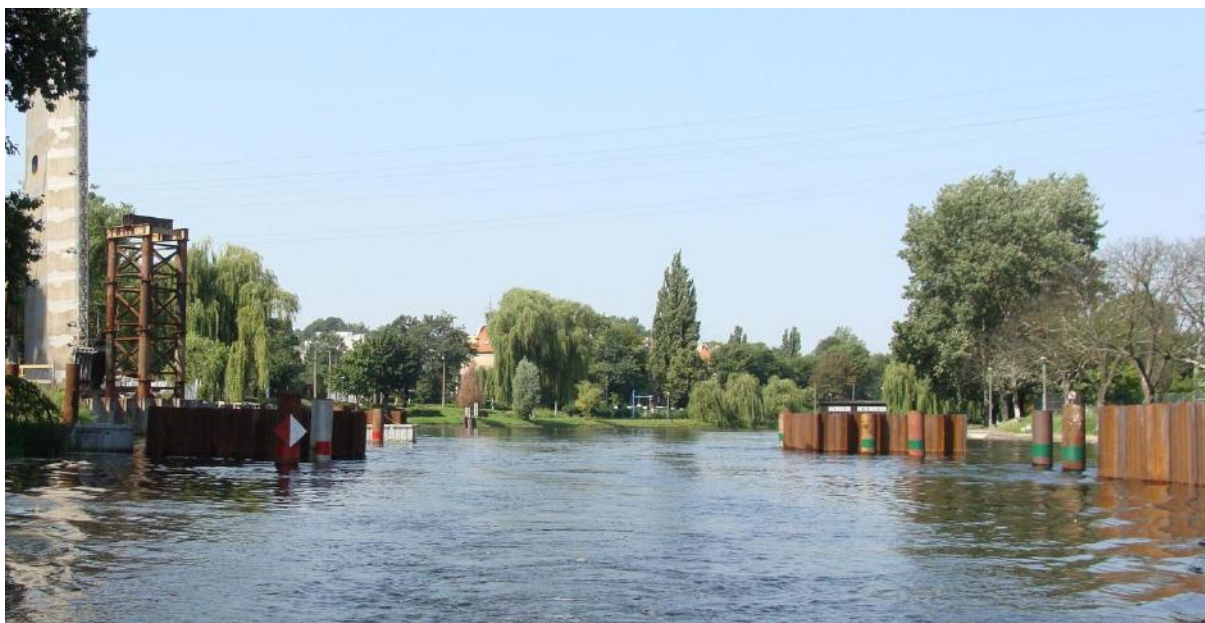
Fot. 4. Budowa Mostu Uniwersyteckiego w Bydgoszczy, 2.08.2012
