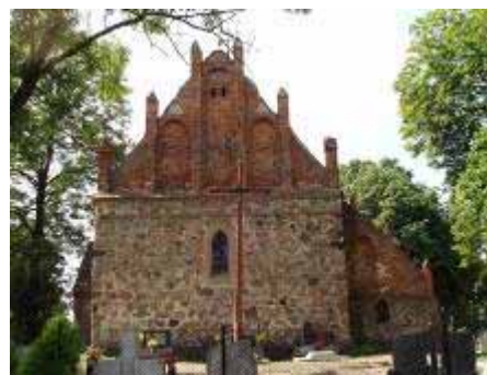
Foto 15. Harmonijna elewacja wsch. kościoła w Brudzawach.
