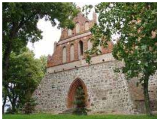
Foto 3. Zachodnia elewacja kościoła w Wabczu.
