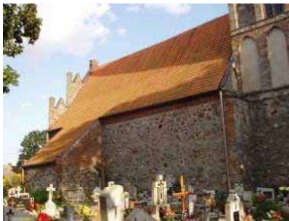
Foto 1. Pn. elewacja nawy kościoła w Dębowej Łące
