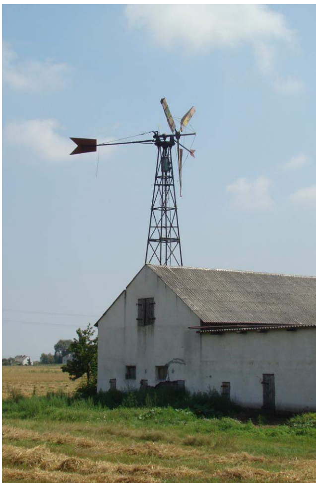
Fot. 1. Prototypowa, przydomowa turbina wiatrowa w Kawęczynie (fot. D. Brykała).
