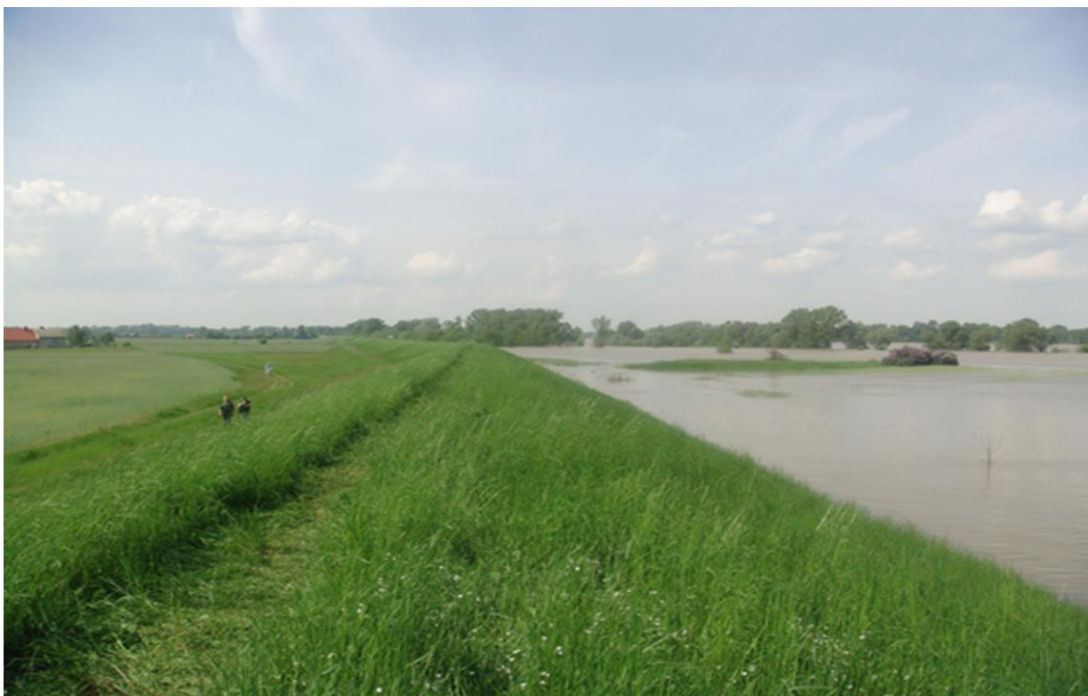
Fot. 5. Wał przeciwpowodziowy chroniący obszar Niziny Ciechocińskiej przed powodzią w maju/czerwcu 2010 roku. Międzywale porastają drzewa i krzewy (fot. Z. Babiński).
