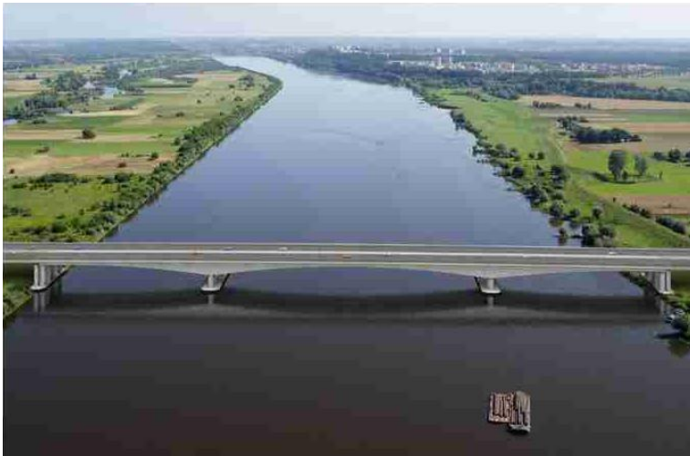
Fot. Most autostrady A1 w okolicy Grudziądza, przykład konstrukcji żelbetonowej. Źródło: https://www.google.com
