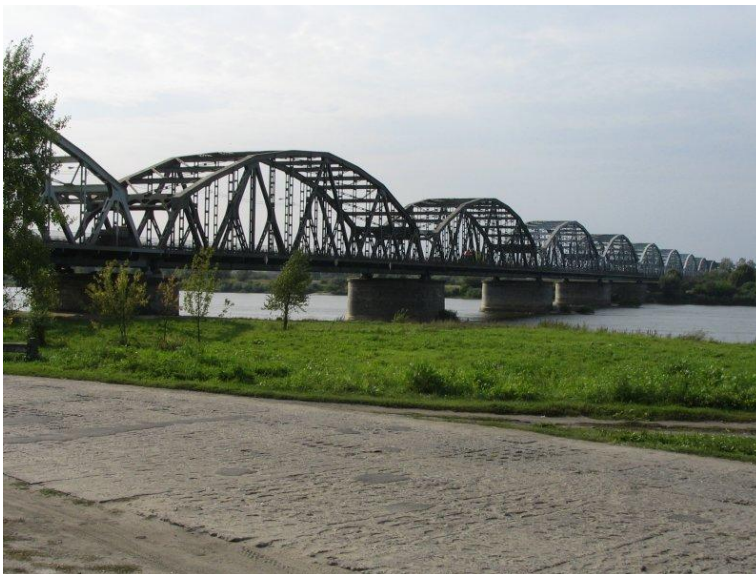
Fot. Most drogowo - kolejowy w Grudziądzu, przykład konstrukcji stalowej charakterystycznej w regionie kujawsko-pomorski Źródło: fotografia H. Rabant
