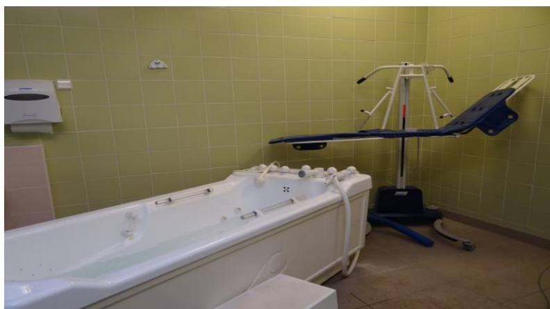
Fot. 9. Wanna strefowa całościowa i podnośnik dla tetraplegików (źródło: ze zbiorów autorów)
