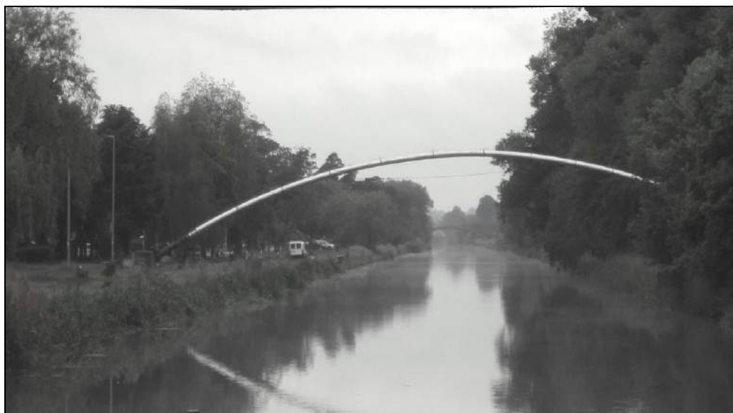
Ryc.16 Trasa wodna z widocznym po lewej stronie traktem pieszym wzdłuż Kanału Bydgoskiego prowadząca w linii prostej do śluzy „Prądy” a następnie do śluzy „Osowa
