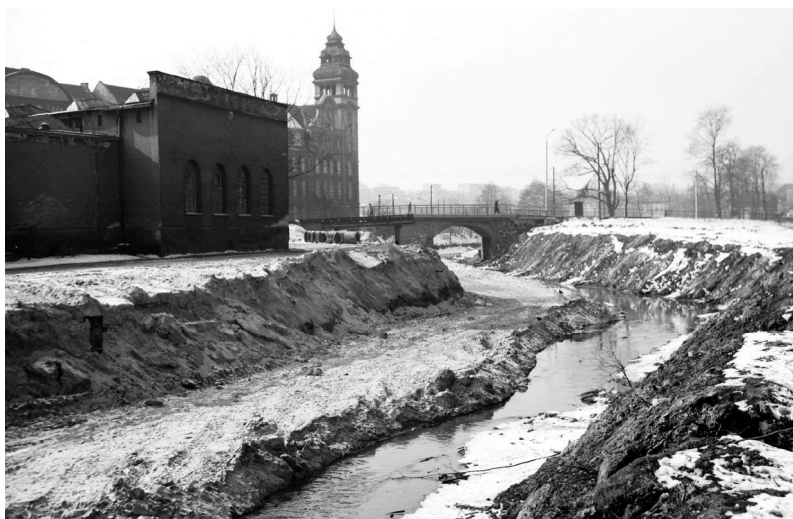
Prace związane z zasypaniem Kanału w latach 1970 – 1972 (ze zbiorów Muzeum Kanału Bydgoskiego)
